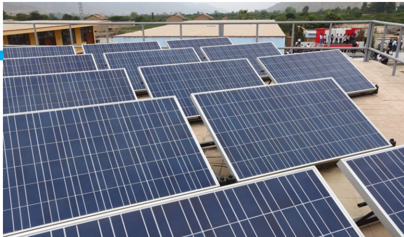
Paneles solares instalados en la UNPRG .
